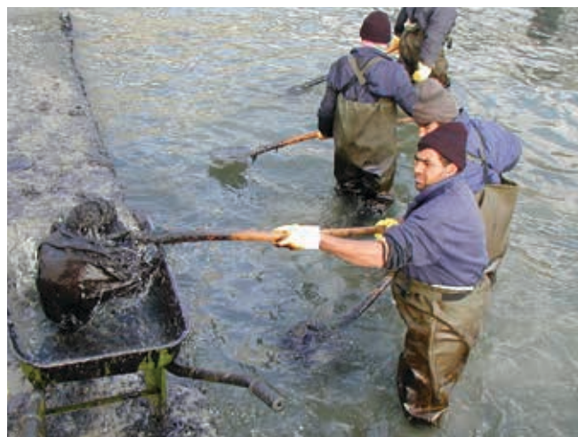
▲ Figura 9: recolección manual de fueloil pesado hundido.
