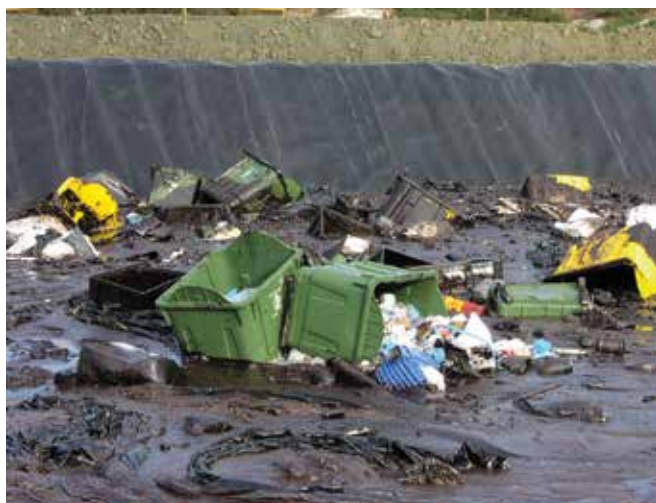
▲ Figura 9: residuos segregados de forma deficiente en un pozo correctamente revestido; se requiere un esfuerzo adicional para separar y tratar los residuos.
