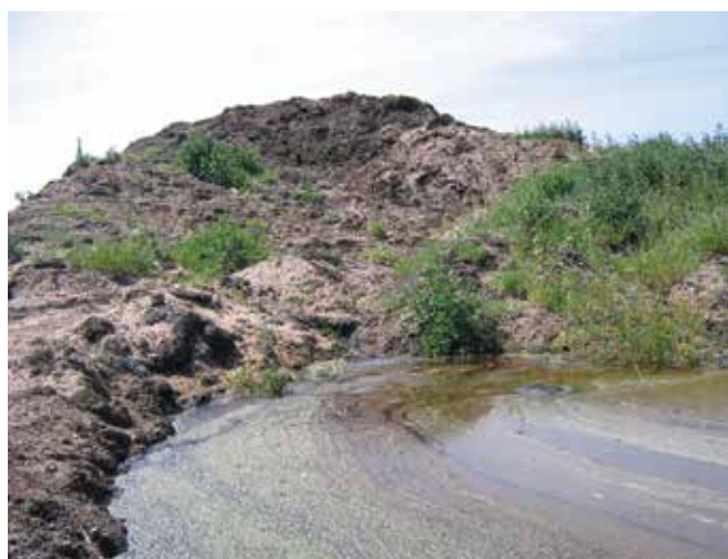
▲ Figura 13: la captura y tratamiento de lixiviado procedente de arena contaminada por hidrocarburos amontonada en el almacenamiento temporal evita la contaminación secundaria del área circundante y de aguas subterráneas.
