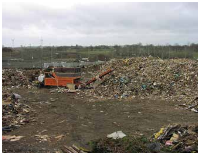
▲ Figura 20: instalación con residuos en relleno sanitario. Los residuos con bajas concentraciones de hidrocarburos pueden colocarse con residuos domésticos bajo condiciones muy controladas.
