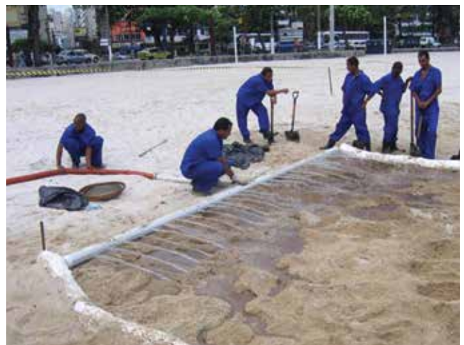
▲ Figura 1: limpieza in situ de arena contaminada por hidrocarburos mediante lavado a baja presión, con barreras adsorbentes desplegadas para capturar los hidrocarburos derramados.
