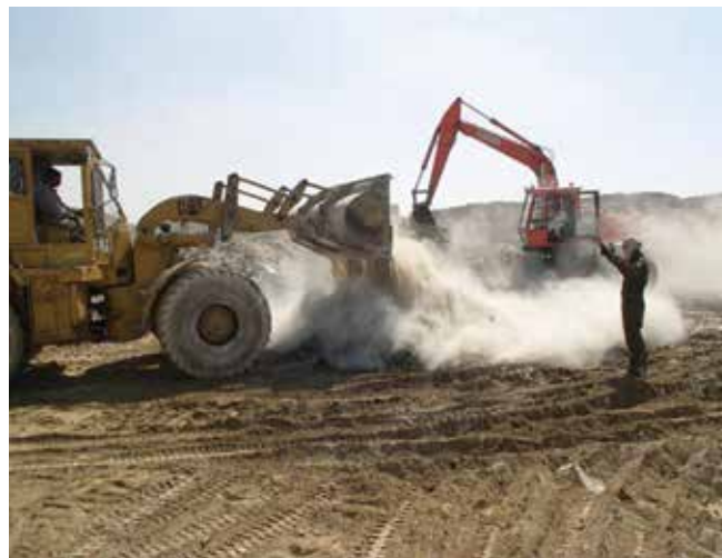
▲ Figura 18: estabilización de desechos oleosos mediante el uso de cal viva.
