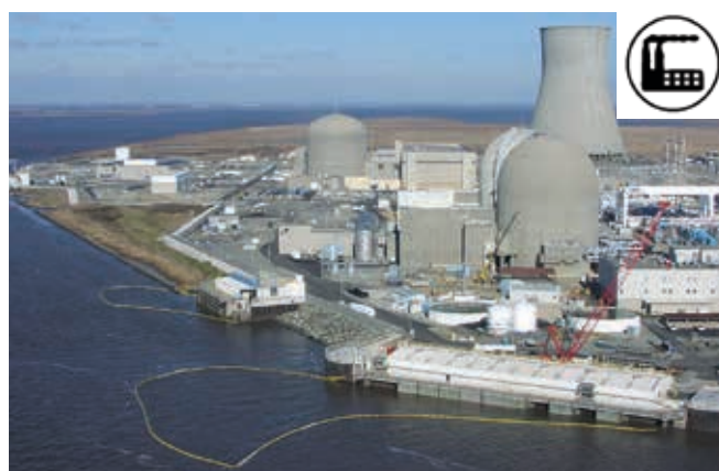
Рис. 6: На переднем плане — электростанция с водозаборными сооружениями. Во избежание попадания в них нефти установлено несколько бонов.
